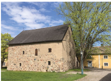
Figur 8. Domprostgården i Linköping, det ännu bevarade stenhuset har uppförts som huvudbyggnad i den medeltida residensgården. Foto Eva Nyström Tagesson.
