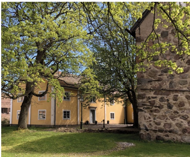
Figur 2. Rhyzeliusgården i Linköping, den tidigare domprostgården, med huvudbyggnaden från 1723 i förgrunden och det medeltida stenhuset till höger. Foto Eva Nyström Tagesson.
